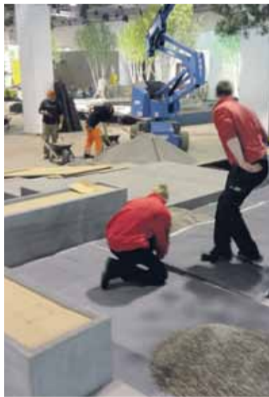
Die Arbeiten am Rohbau des Stands haben begonnen.
